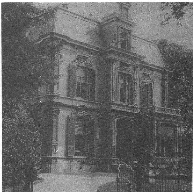
De villa "Felicitas" woonhuis van de familie G. Avelingh aan de Stationsstraat hoek Stationsplein. ca. 1900
